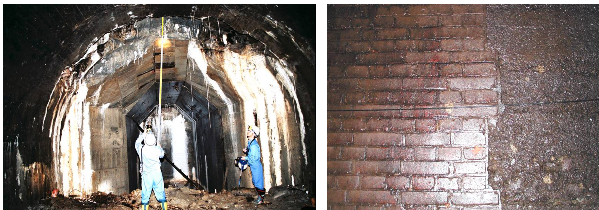
写真一補2 旧志津川導水路内の状況
