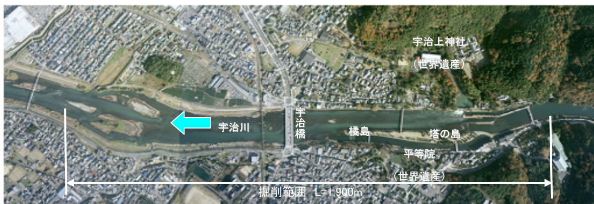
写真-4 宇治川塔の島地区の掘削範囲
