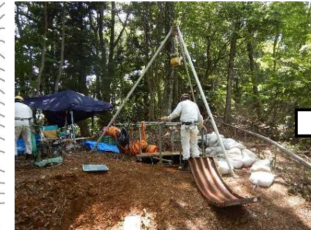
閉塞中 ダムサイト立坑
