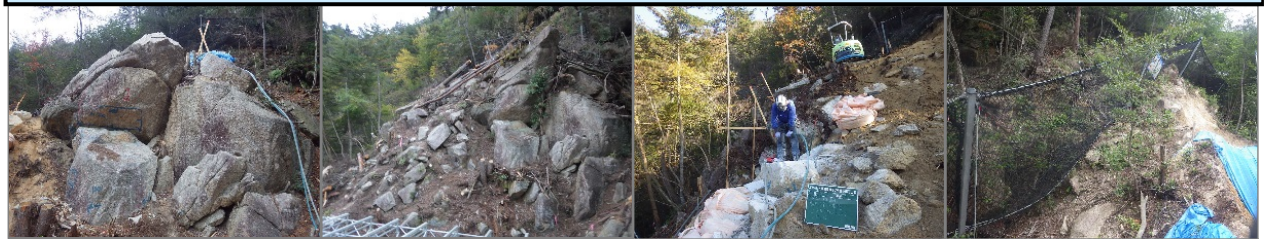
【箇所⑦】対策実施箇所（新7号橋下部その他工事）
