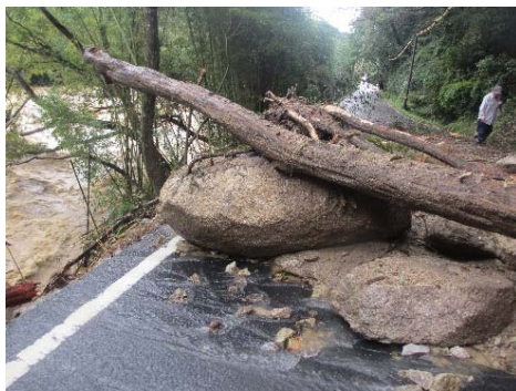
H25台風18号による現道への落石
