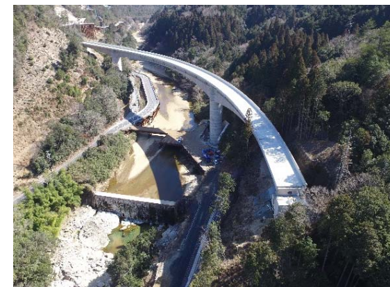
付替県道大津信楽線 牧町天空大橋 (新3号橋)
