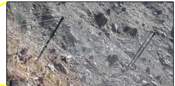
落石防護網工
