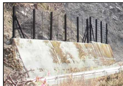
落石防護柵工
