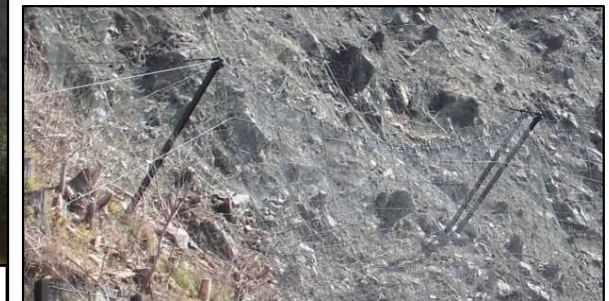
落石防護網工
