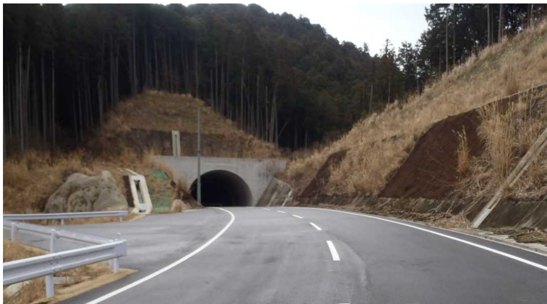
北野トンネル(現況)
