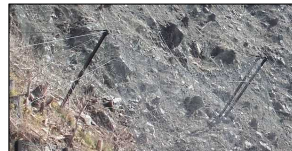
落石防護網工
