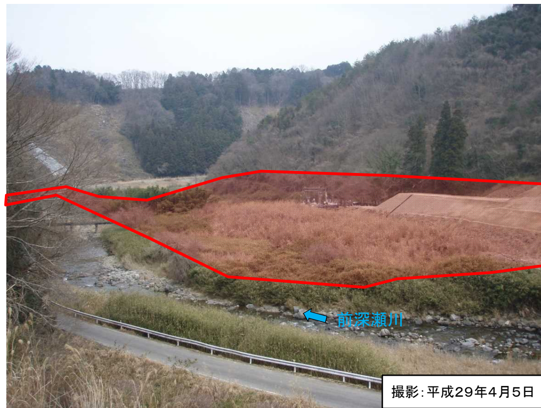
下流工区現況写真
