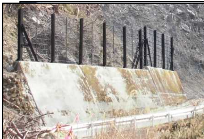
落石防護柵工
