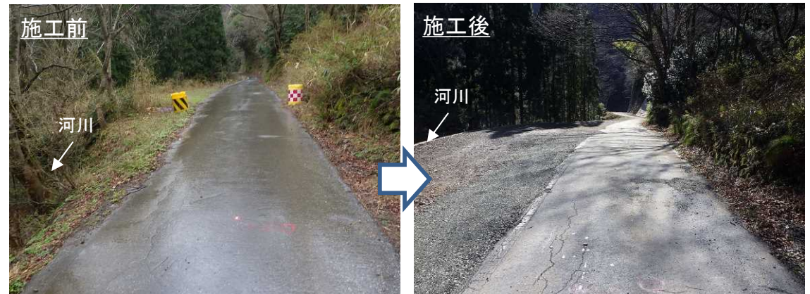
令和2年度 道路復旧状況(鷺見地区)
