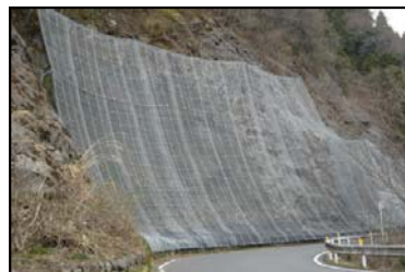
落石防護網工
