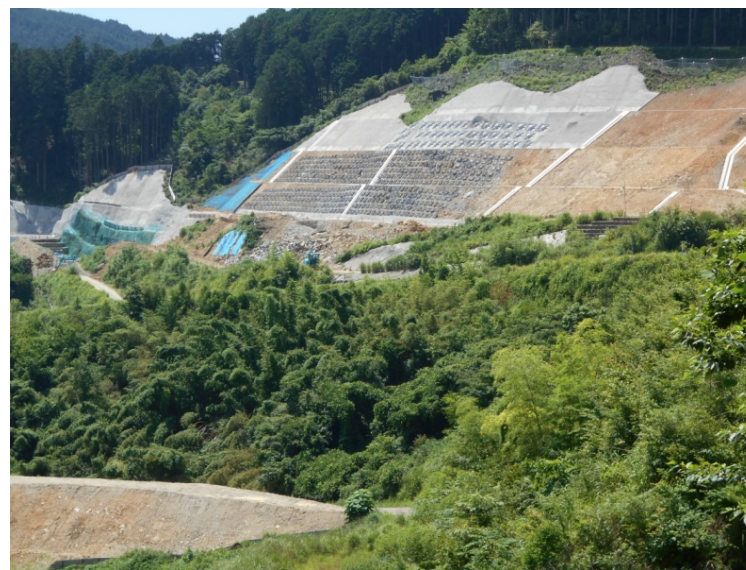
起点側より工事箇所を望む
