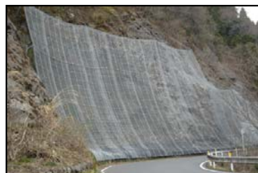
落石防護網工
