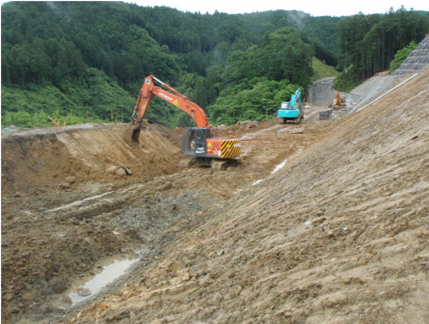
当初想定どおりの法面
