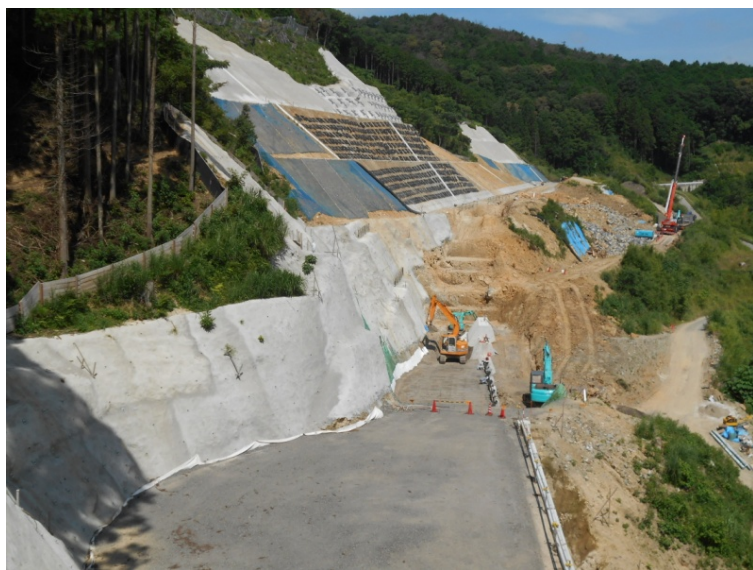
終点側より工事箇所を望む
