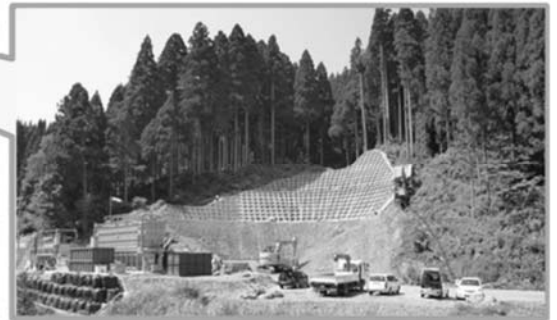
■ 平成 29 年 5 月 導水トンネル吐口着工
