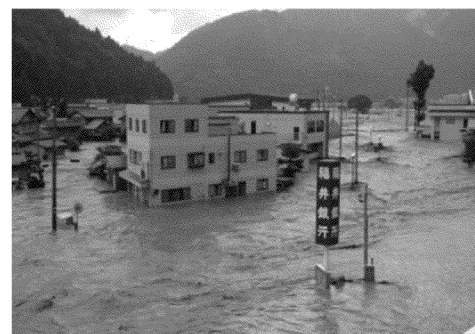
足羽川流域(福井市朝谷島付近) 平成16年7月18日 出水
