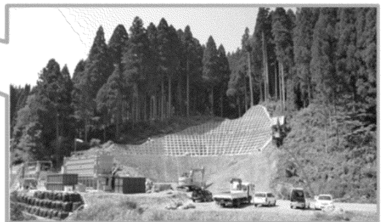
■ H29.5 導水トンネル吐口着工
