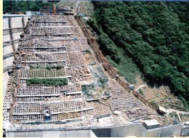
ダム建設中 (H11年8月)
