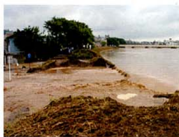
福井市春日地区破堤箇所
