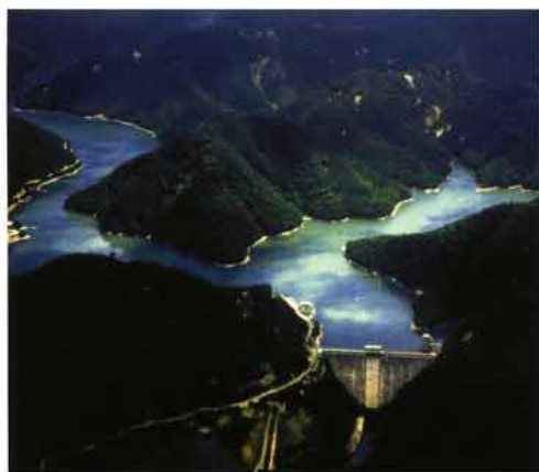
ダムの規模 堤高 76m 総貯水容量 58,806千㎡
