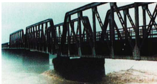
昭和56年7月洪水（梅雨前線） 洗掘のため傾いた高屋橋（県道福井三国線）の橋脚
