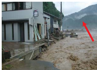
護岸と道路が流失(旧美山町西河原)
