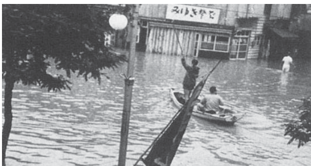
昭和34年9月洪水（伊勢湾台風） 福井市城の橋通りの浸水状況
