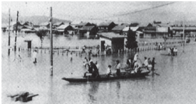
昭和28年9月洪水（台風13号） 福井市花月町付近の浸水状況
