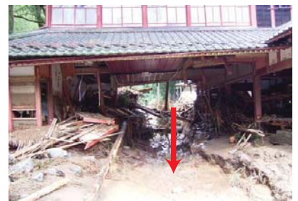
民家の中を濁流が通過(池田町松ヶ谷)
