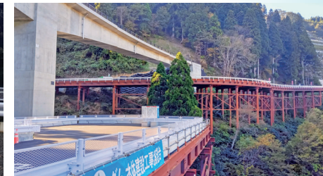
付替県道7号橋
