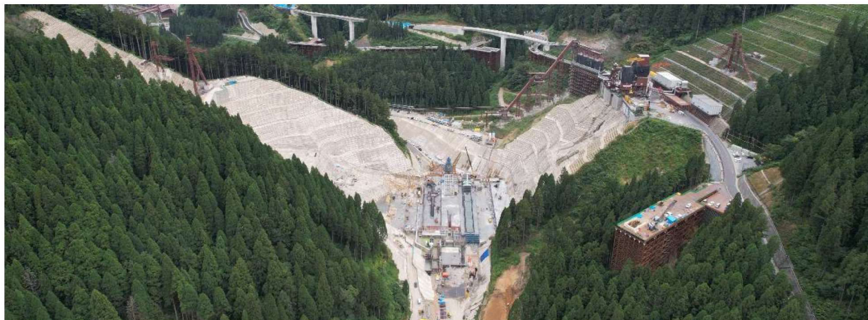
[4]足羽川ダム本体建設(第1期)工事
