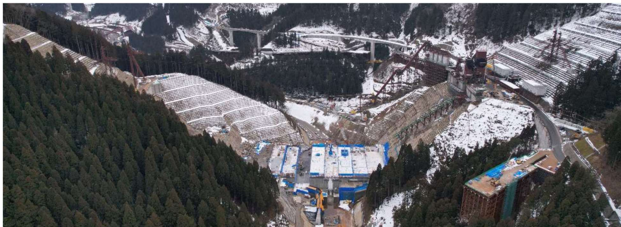
[4]足羽川ダム本体建設(第1期)工事
