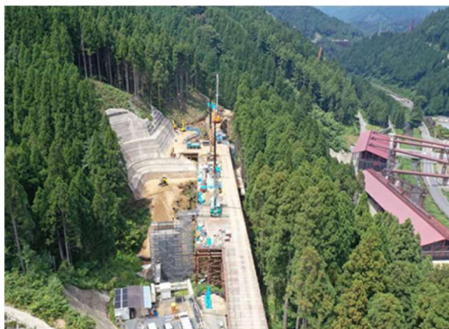
[24]足羽川ダム付替県道10号橋 仮栈橋設置他工事
