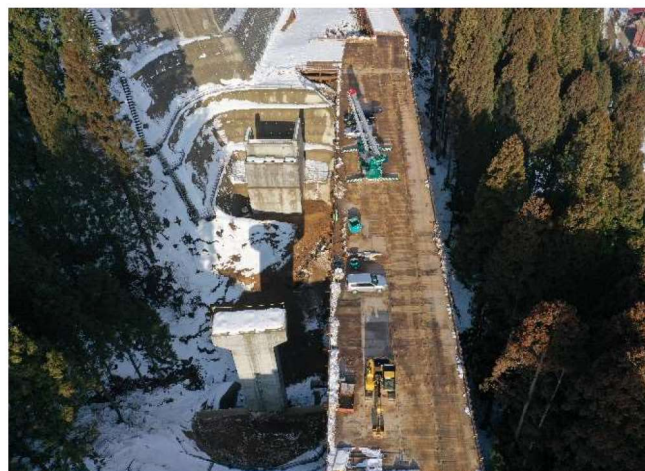
[24]足羽川ダム付替県道10号橋 仮棧橋設置他工事
