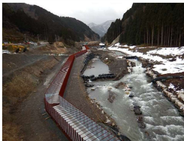
[9]足羽川ダム水海川貯砂ダム工事
