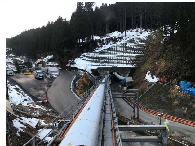
[6]水海川導水トンネル2期工事
