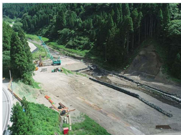
[9]足羽川ダム水海川貯砂ダム工事
