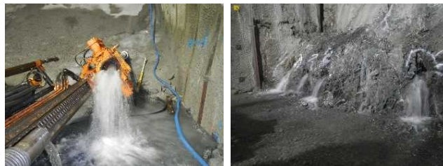
【調査兼水抜きボーリング】
