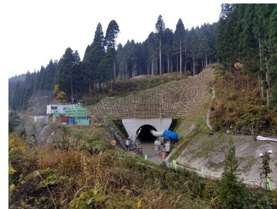
[4]水海川導水トンネル2期工事
