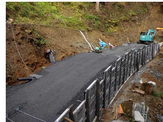
[20]付替町道広瀬千代谷線 千代谷3工区工事
