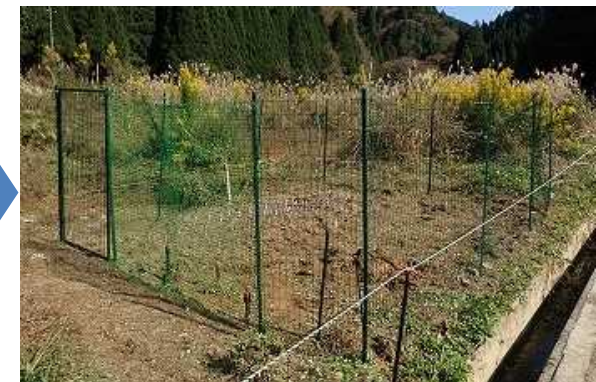
侵入防止柵設置状況 令和2年10月30日 撮影
