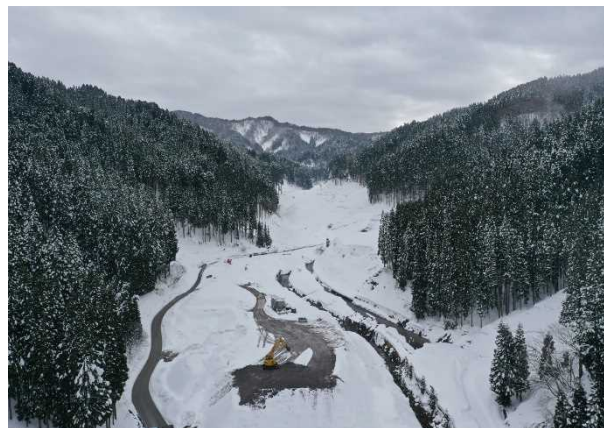
[10]足羽川ダム原石山掘削他工事 (金見谷下流より) R3.2.19時点
