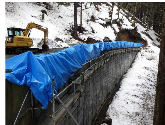
[20]付替町道広瀬千代谷線 千代谷3工区工事 R3.2.16時点
