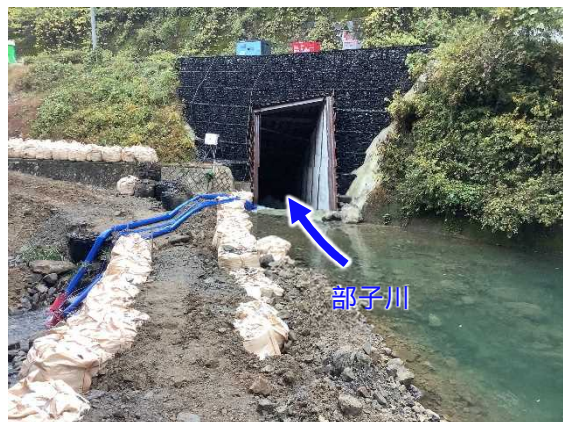
[10]足羽川ダム原石山掘削他工事 (転流工 呑口部) 令和2年11月に転流開始
