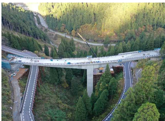
[6]付替県道7号橋上部工事 令和2年12月末に施工完了
