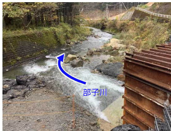
[10]足羽川ダム原石山掘削他工事 (転流工 吐口部) 令和2年11月に転流開始
