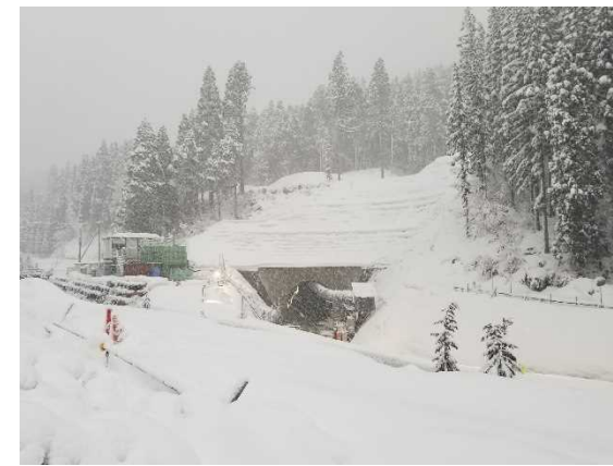
[4]水海川導水トンネル2期工事 R3.2.17時点
