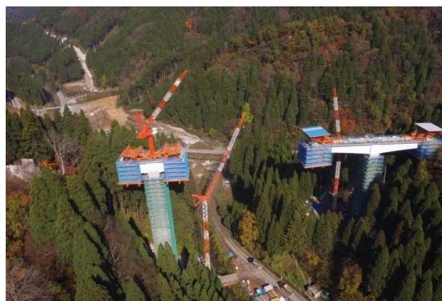
[2]付替県道11号橋工事
