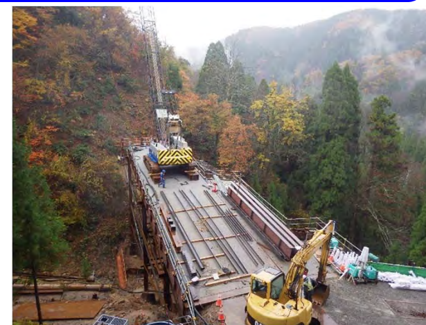
⑪2号工所用道路3工区工事
