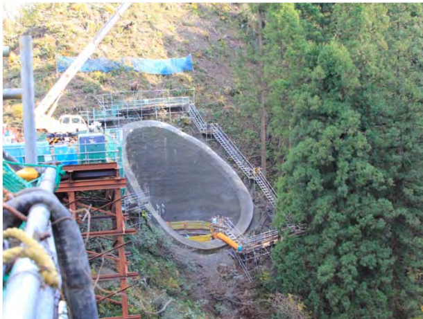
④付替県道8号橋工事
