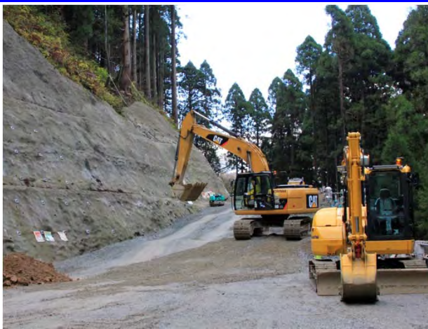
⑩3号工所用道路4工区工事
