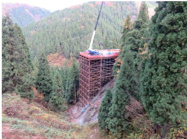
③付替県道7号橋工事
