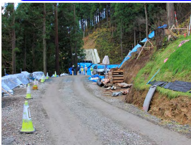
⑥4号工所用道路下小畑4工区工事
