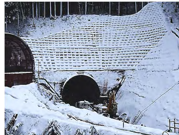
⑬水海川導水トンネル I 期工事
