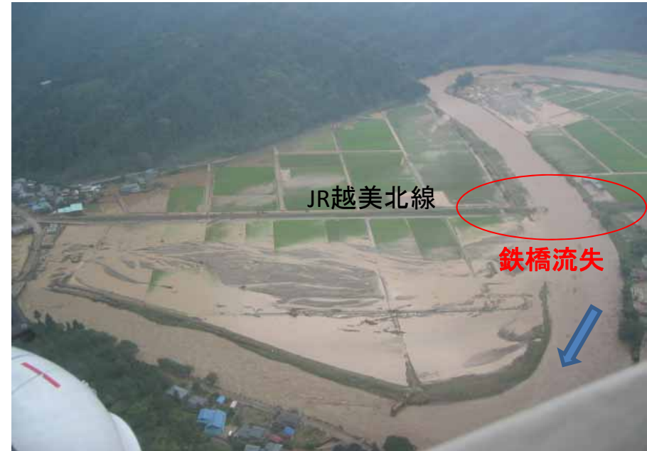
福井市(旧美山町)高田の鉄橋流失(JR第4号橋梁)
