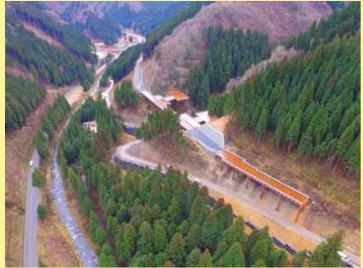
1号工事用道路 (H28.12)
