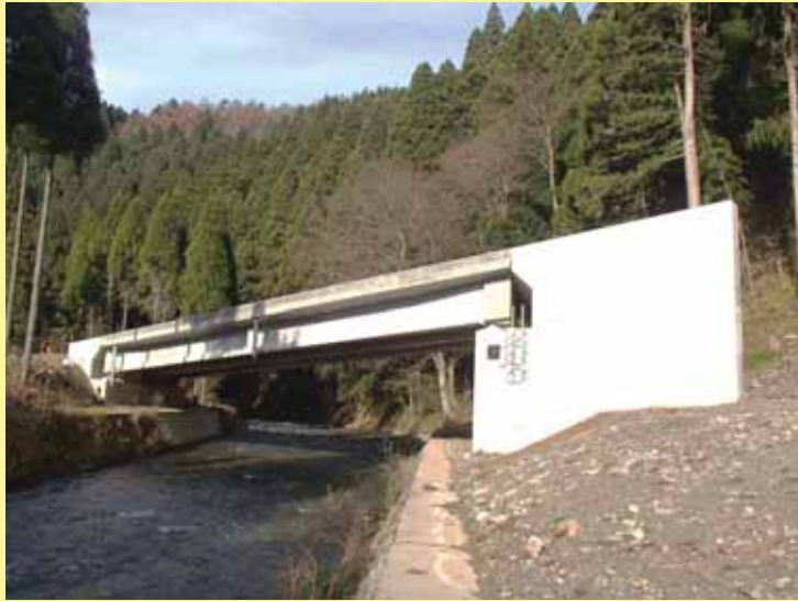
付替県道1号橋 (H27.12完成)
