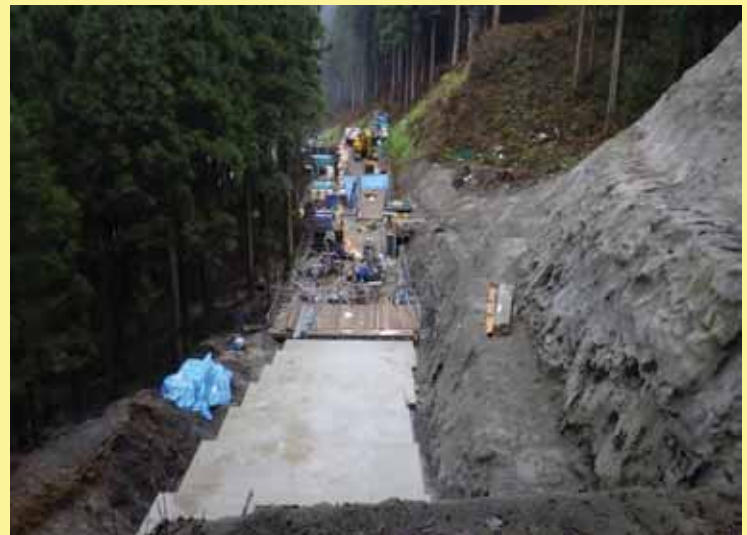
3号工事用道路 (H28.12)
