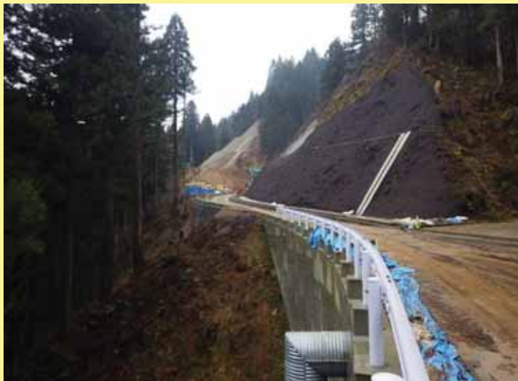
4号工事用道路 (H28.12)
