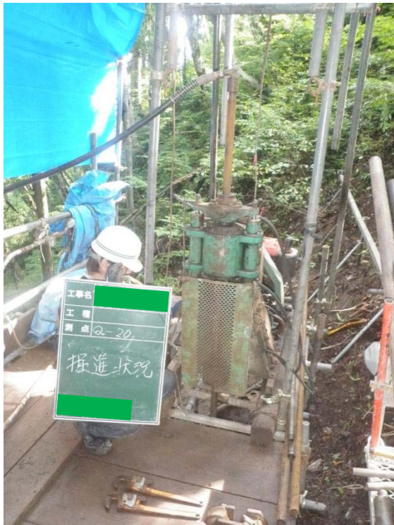
ボーリング調査実施状況
