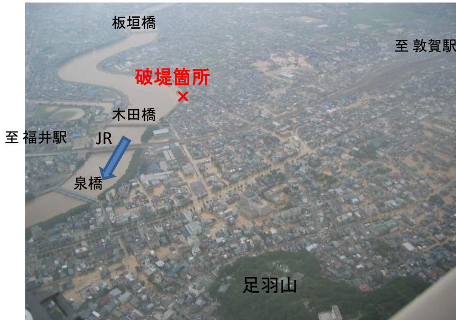
福井市街地 破堤箇所周辺の浸水状況
