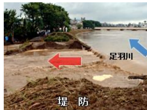
堤防の破堤(福井市春日地区)
