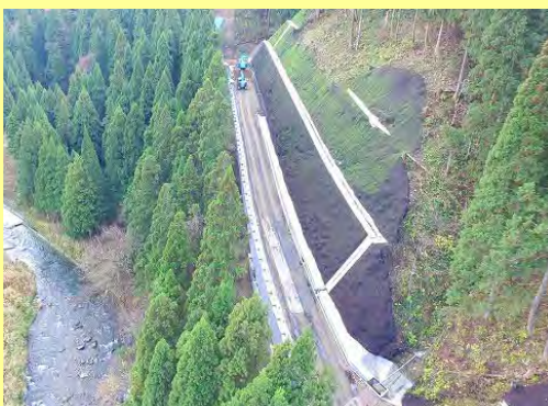
4号工事用道路 (H27.12)
