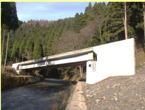
付替県道1号橋 (H27.12完成)
