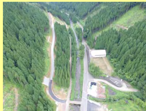
1号工事用道路進入部 (H27.9完成)
