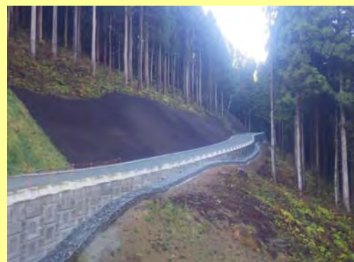
3号工事用道路 (H27.12)
