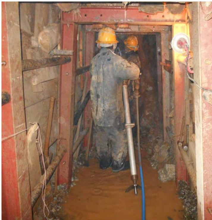
横坑調査実施状況
