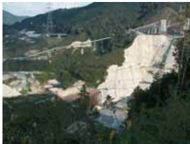
● ダムの堤体の工事の例
