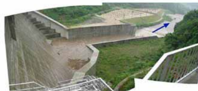
【ダム下流側 減勢工】
