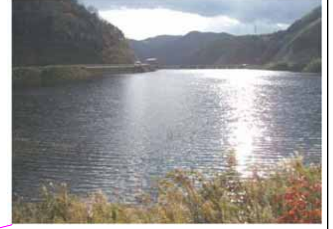
サーチャージ水位EL72.7(H17. 12. 7)
