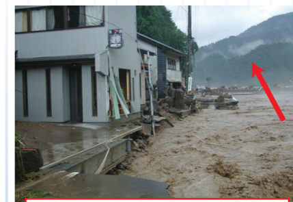
護岸と道路が流失(旧美山町西河原)
