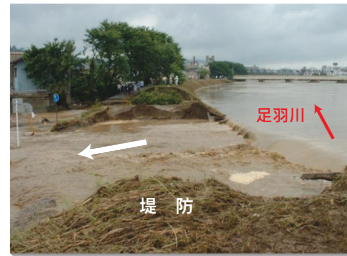
堤防の決壊状況(福井市春日)
