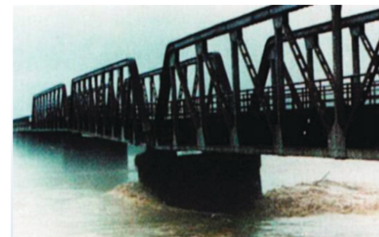
昭和56年7月洪水(梅雨前線) 洗掘のため傾いた高屋橋(県道福井三国線)の橋脚
