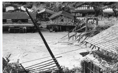
昭和40年9月洪水(奥越豪雨) 西谷村(現大野市)の被災状況
