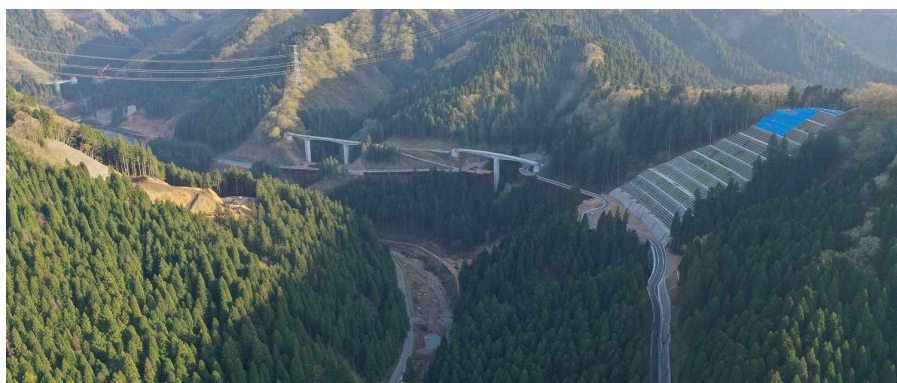
ダム本体(下流から上流を望む)
