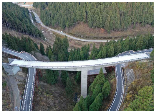
付替県道7号橋(R2.12完成)
