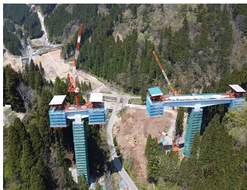
付替県道11号橋
