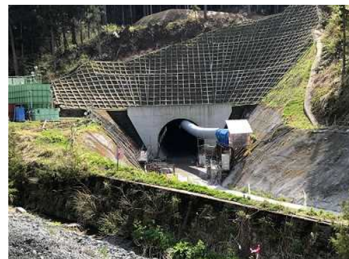
水海川導水トンネル
