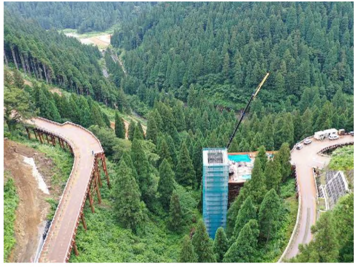
[8]付替県道7号橋上部工事
