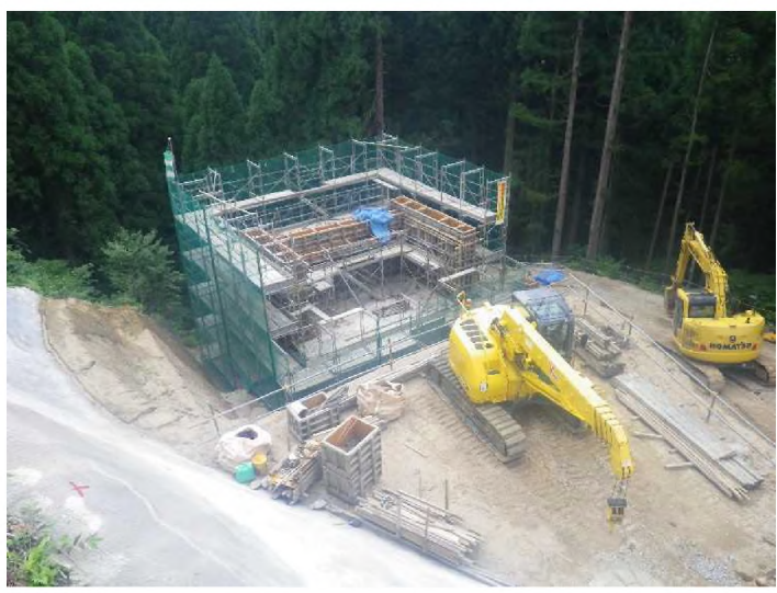
[8]足羽川ダム千代谷地区改良工事
