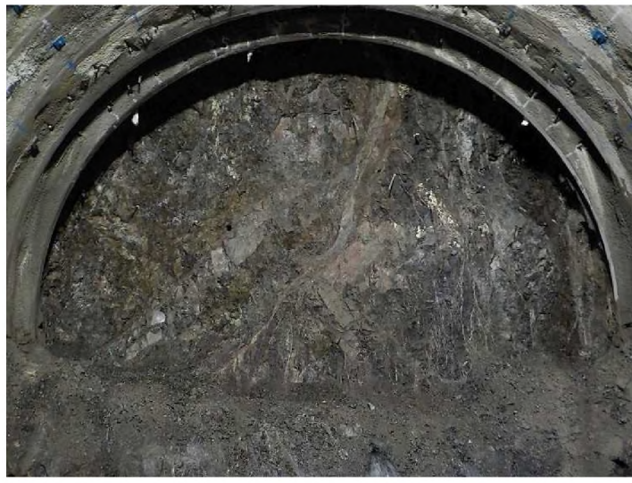
[5]水海川導水トンネル I 期工事
