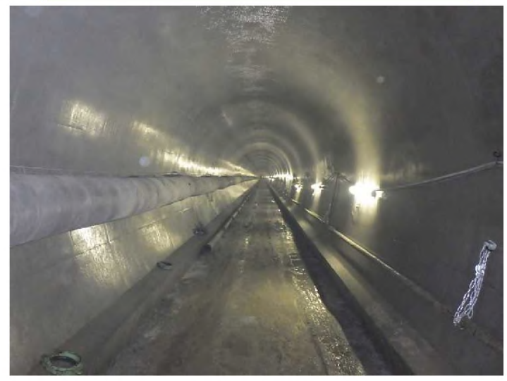
[7]足羽川ダム転流工事
