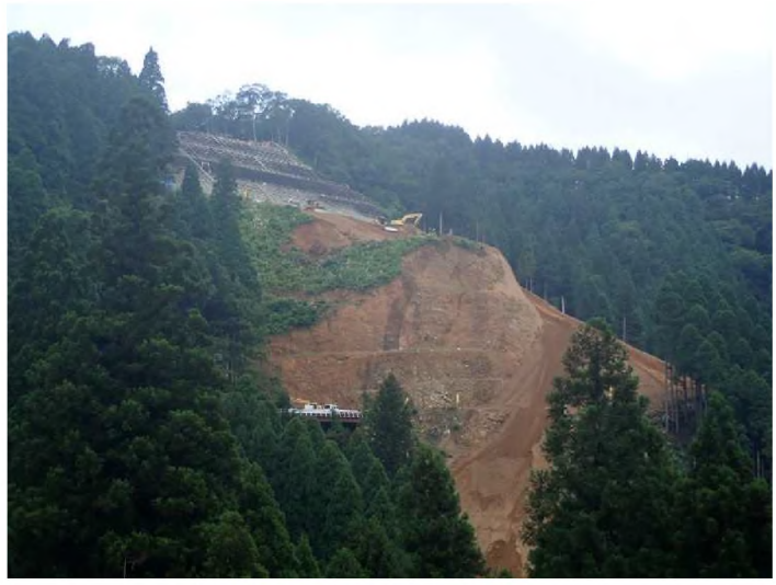
[1]付替県道3工区工事
