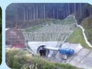
導水トンネル工事
