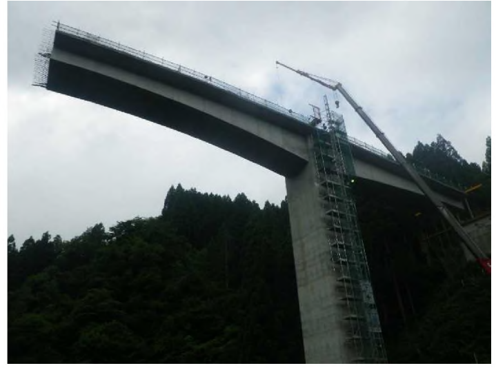
[3]付替県道8号橋工事
