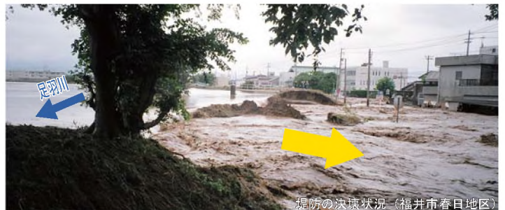
堤防の決壊状況(福井市春日地区)
