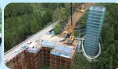
付替県道(橋梁)工事
