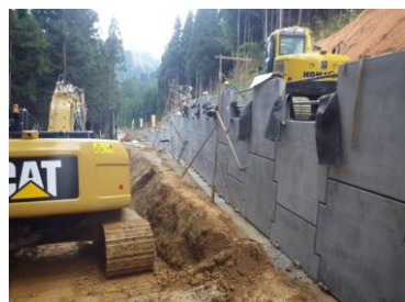
1 号工事用道路 (H26.11 撮影)
