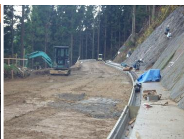
4 号工事用道路 (H26.11 撮影)
