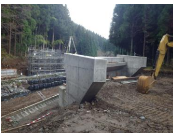
付替県道 1 号橋 (H26.11 撮影)
