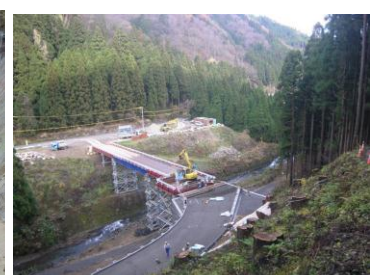
3 号工事用道路 (H26.11 撮影)
