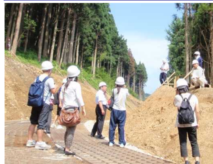
工事用道路の見学
