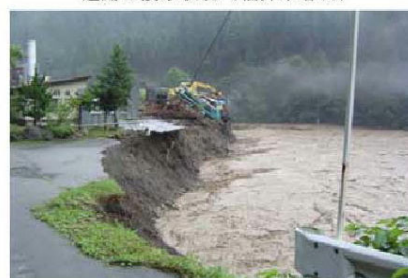
河岸侵食状況 (池田町持越)
