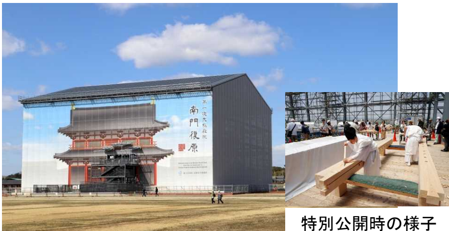
【南門復原整備工事の素屋根】
