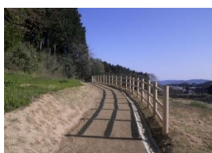
転落防止柵の修繕
