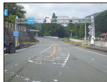
遮断機による道路通行止め
