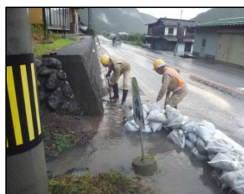
冠水対策処理
