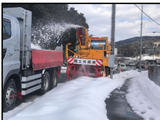
拡幅除雪 (ロータリー除雪)
