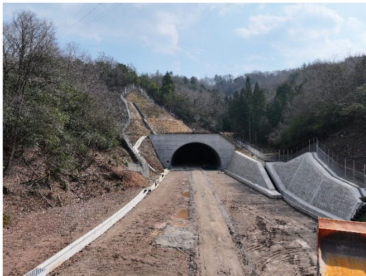
⑤ とべら 戸牧トンネル
