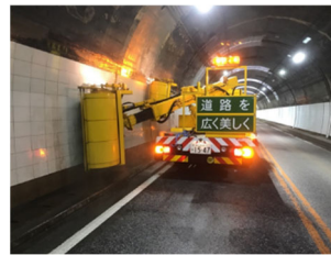
トンネル清掃
