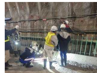
ロックボルト引抜試験を体験
