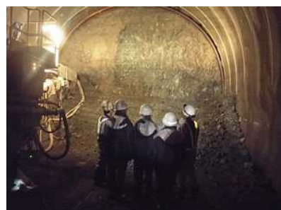
約200m掘削が進んだ切羽部分の地質状況を確認
