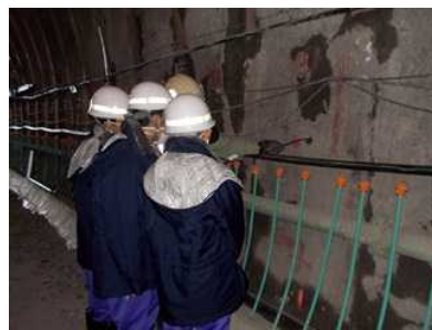
孔内カメラを使い吹付コンクリートの巻厚測定を体験
