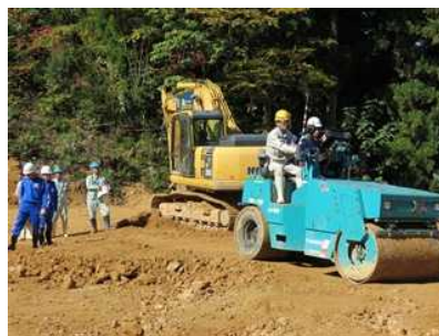
情報化施工技術による 盛土の締固作業を体験
