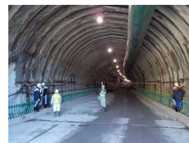
鋼製支保工の出来形検測を体験
