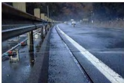
②急勾配箇所への 定置式溶液散布装置の設置 (約2km区間で設置済み)
