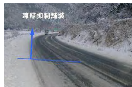
③凍結抑制舗装の施工 (約14km・車線で施工済み)
