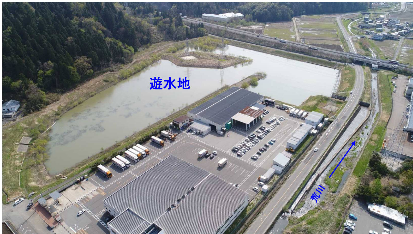
荒川において整備した遊水地の事例
