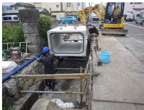
市街地での雨水渠整備状況
