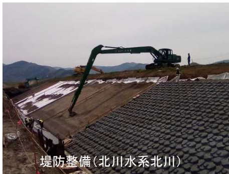
河道掘削（北川水系北川）
