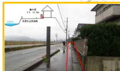
江古川地区の輪中堤整備(福井県)
