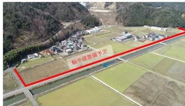
輪中堤整備（北川水系江古川）
