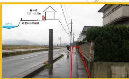
江古川地区の輪中堤整備(福井県)
