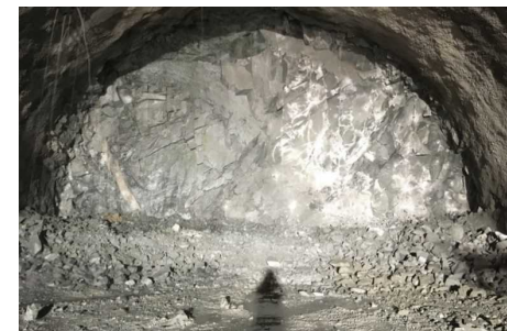
勝原IC側切羽の状況(R2.11: 支保パターンC I)
