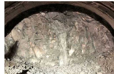
勝原IC側切羽の状況(R3.9: 支保パターンD II)
