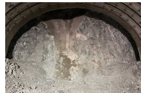
勝原IC側切羽の状況(R3.6: 支保パターンD I)
