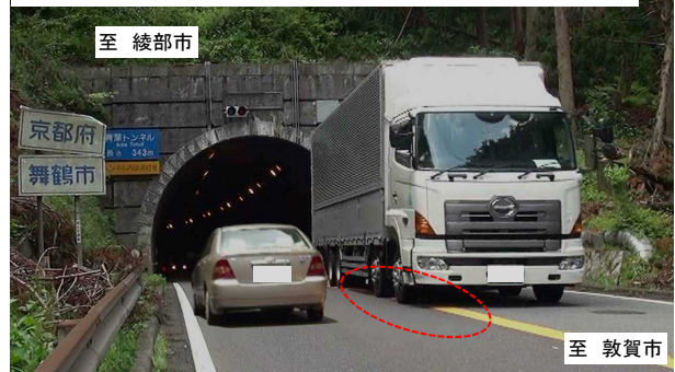
写真2: 大型車通行状況(幅員狭小のため中央線越線)
