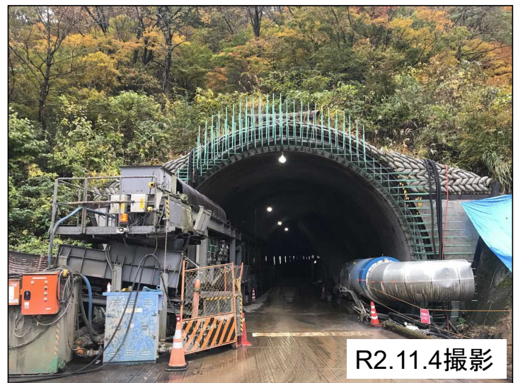
掘削後（福井側）
