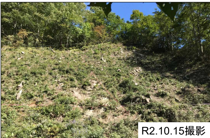
トンネル坑外貫通前（岐阜側）
