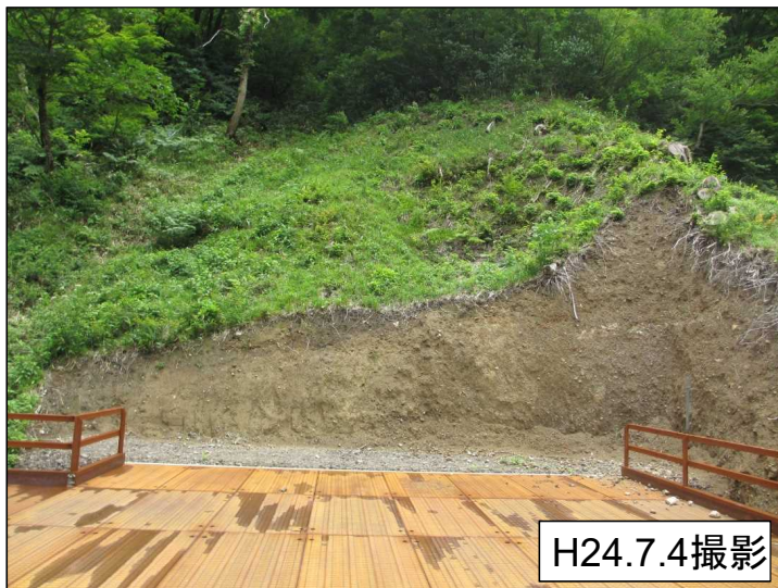
掘削前（福井側）
