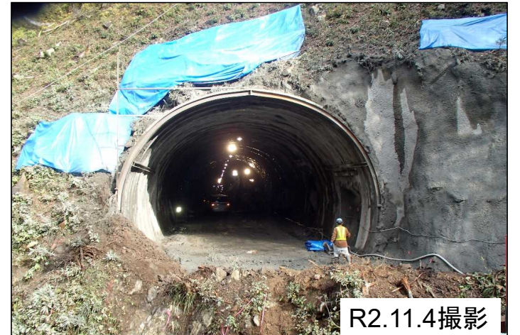
トンネル坑外貫通後（岐阜側）
