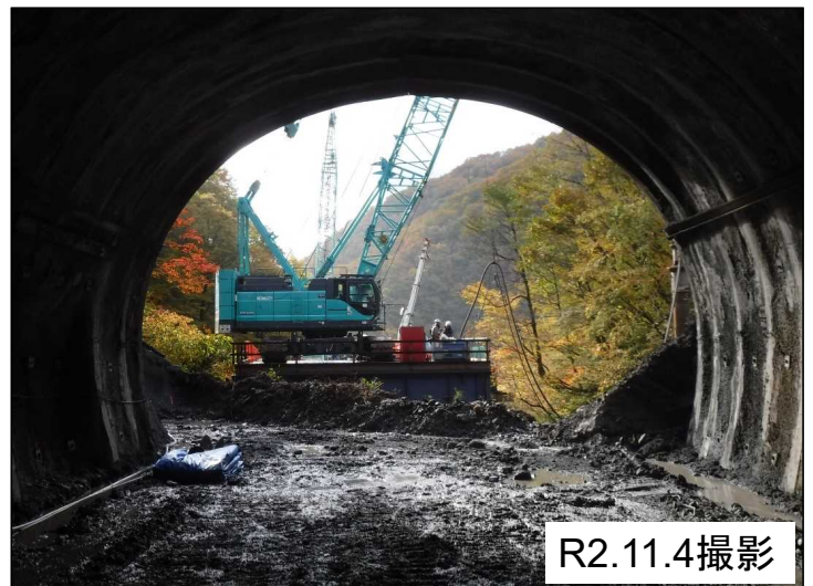
トンネル坑内貫通後（岐阜側）
