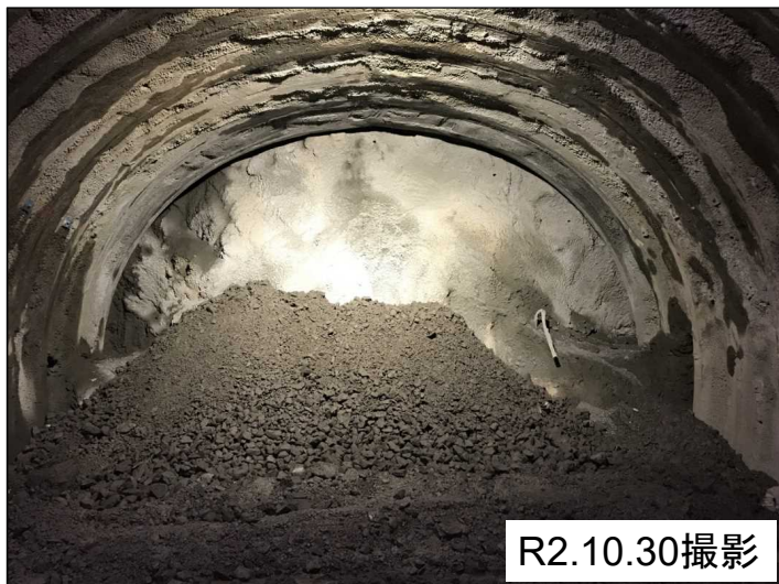
トンネル坑内貫通前（岐阜側）
