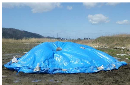
③ブルーシートによる養生
