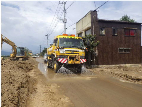
【九州北部豪雨時の散水車作業写真】 (ハイウェイ・リバーメンテナンス(株))
