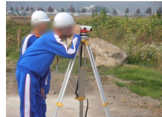
九頭竜川の工事現場で測量を体験
