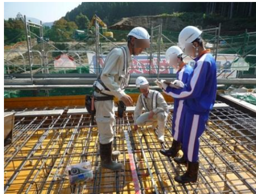
中部縦貫自動車道の工事現場で出来形検測を体験
