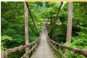
かずら橋: 葛類で作られた珍しいつり橋
