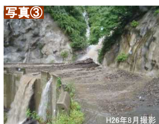
降雨による路体崩壊
