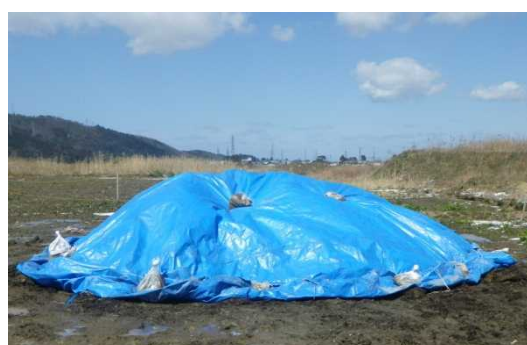
③ブルーシートによる養生
