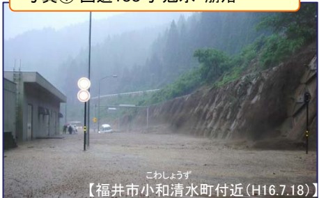
写真① 国道158号 冠水・崩落
