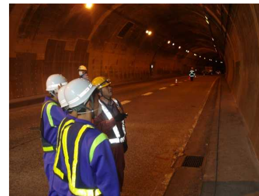
トネル覆工コンクリートの状況を確認
