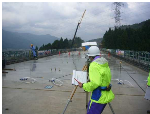
高架橋上部工事で出来形検測を体験
