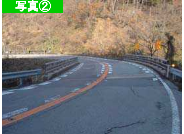
写真②：大野市長野の急カーブ (大野市長野付近)
